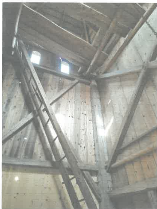
Fot. 8 Konstrukcja słupowo-ryglowa dzwonnicy
