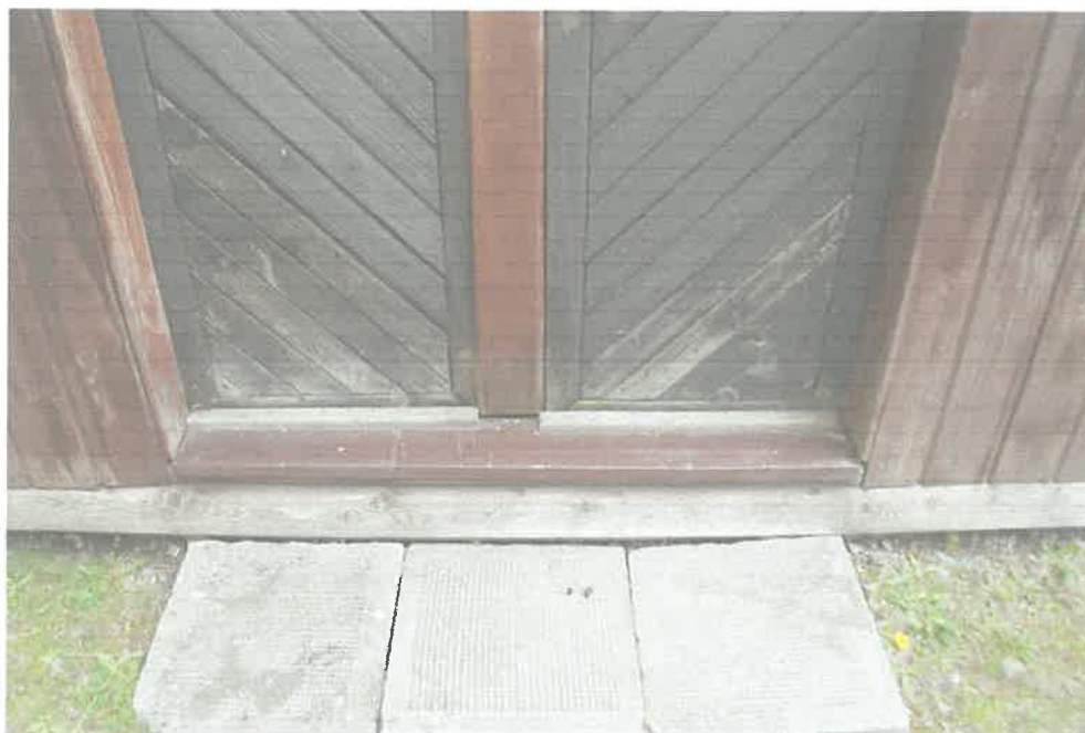
Fot. 3 Płyty betonowe przed wejściem.
