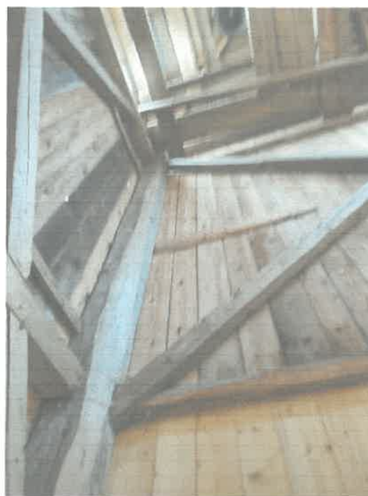
Fot. 9 Konstrukcja słupowo-ryglowa dzwonnicy
