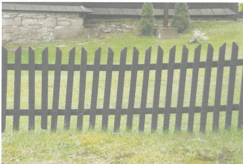
Fot. 16 Drewniane ogrodzenie.
