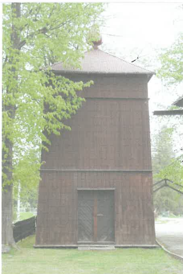
Fot. 19 Dzwonnica elewacja zachodnia i południowa
