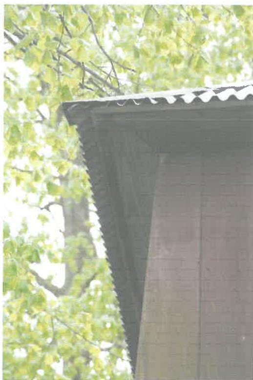
Fot. 11 Pokrycie z blachy trapezowej – zbliżenie na okap.
