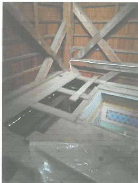
Fot. 14 Konstrukcja słupowo-ryglowa wieży
