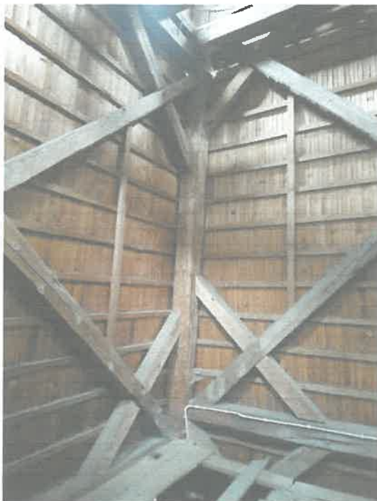
Fot. 13 Konstrukcja słupowo-ryglowa wieży
