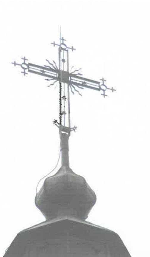
Fot. 25 Elementy metalowe dachu
