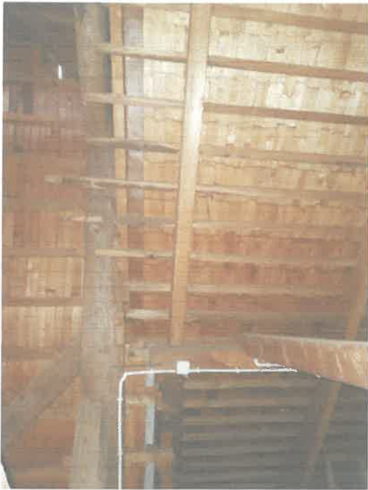
Fot. 11 Styk połaci północnej dachu nawy z wieżą
