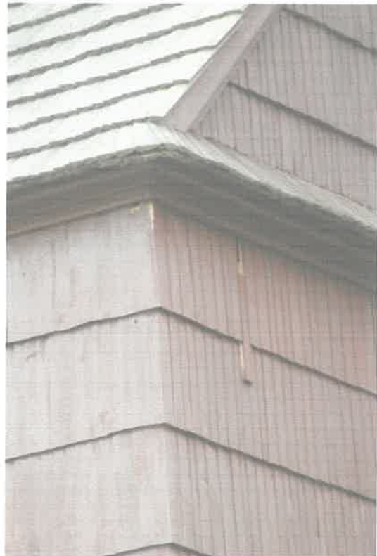
Fot. 10 Ubytki w poszyciu elewacji z gontu
