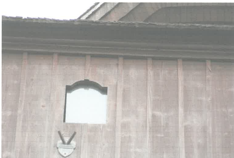
Fot. 19 Okienka w wieży tymczasowo zabezpieczone szkłem.
