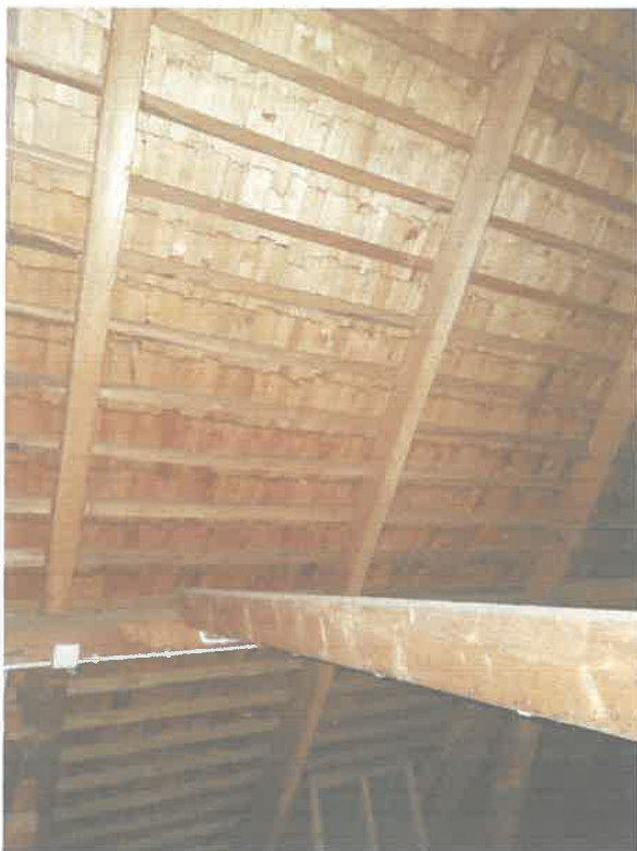
Fot. 17 Pokrycie z gontu widoczne od środka
