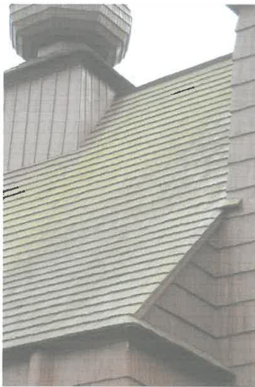
Fot. 18 Pokrycie z gontu na północnej połaci dachu
