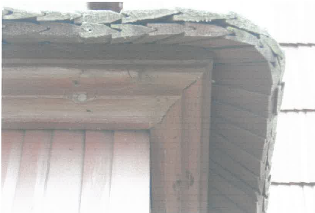
Fot. 16 Profilowany gzyms okapowy
