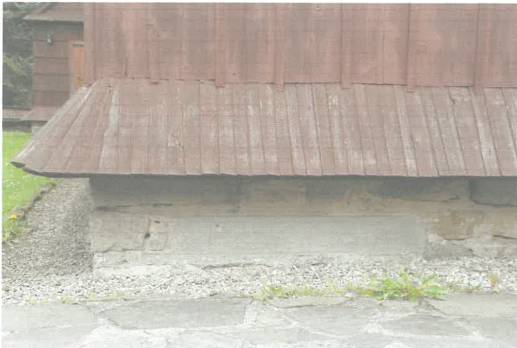
Fot. 4 Kamienna podmurówka – uzupełnienia z elementów betonowych.
