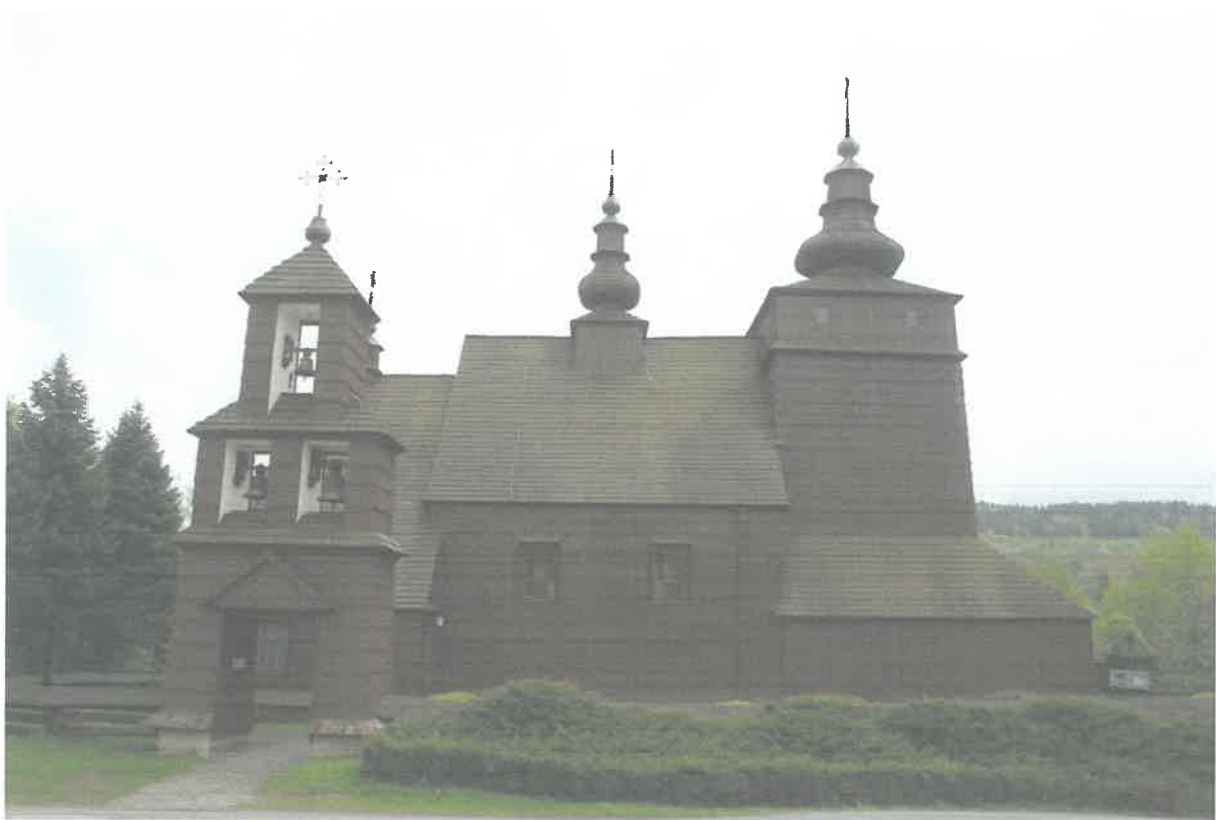
Fot. 28 Elewacja północna cerkwi.
