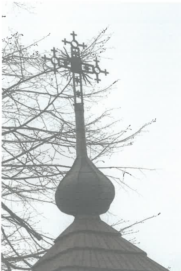
Fot. 24 Elementy metalowe dachu
