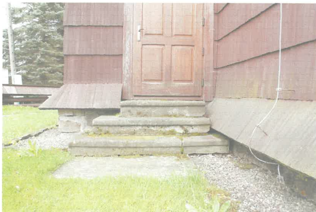
Fot. 7 Schody zewnętrzne przed wejściem do zakrystii.
